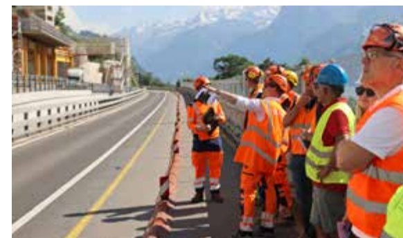
Auch entlang der vielbefahrenen Strasse wird fleissig gearbeitet.
