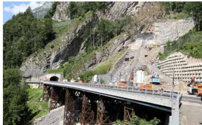
Die Arbeiten am Ausgang des Morschacher Tunnels stellen hohe Anforderungen an Planung und Ausführung.
